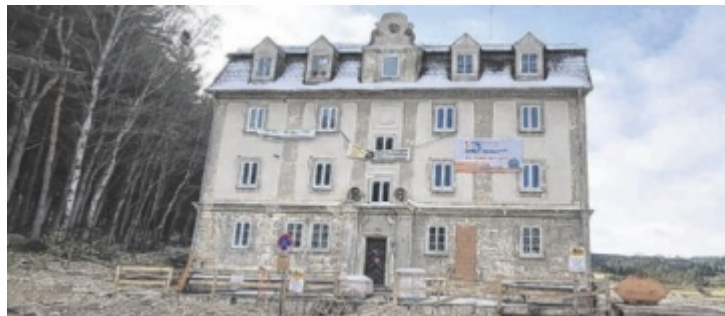
Nahe der Staatsgrenze zu Tschechien entstehen neue Wohnräume.
