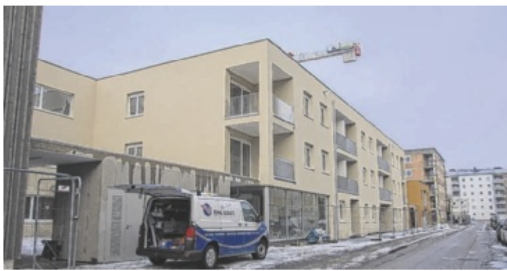
Derzeit läuft beim Wohnprojekt der Innenausbau. Foto: Magistrat Steyr/Presse
