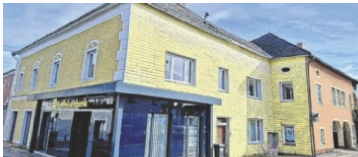
Im Pürchenfellnerhaus soll Wohnen mit Service entstehen
