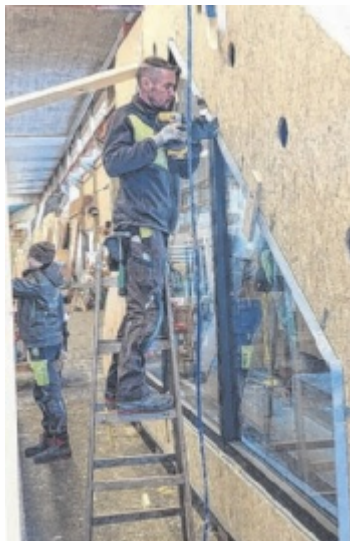
In der Werkshalle stehen die Holzbauelemente Wand an Wand. Foto: Greindl
