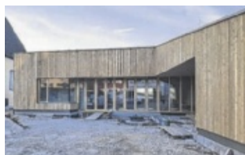
Neben der Michaelnbacher Kirche entsteht ein neues Pfarrheim. Foto: Tips
