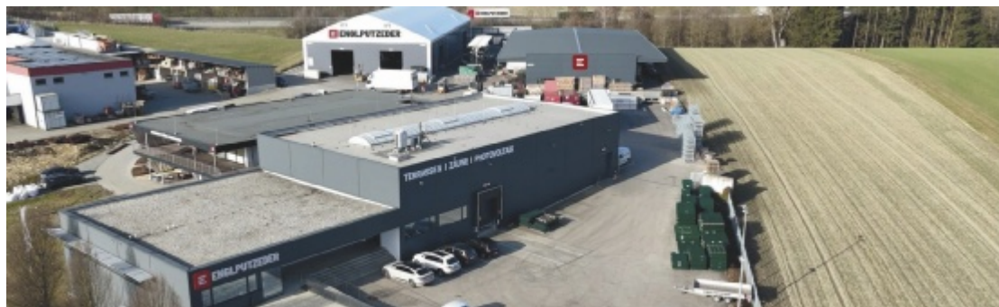
ENGLPUTZEDER setzt auf Innovation und investiert sechs Millionen Euro am Standort Andrichsfurt.
