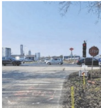
Kreuzung wird generalsaniert. Foto: Tips
