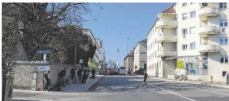
Der stadteinwärts führende Fahrstreifen der Tomitzstraße (links) wird für Grabungsarbeiten eingeengt.
