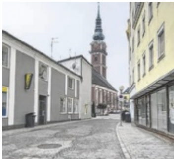
Die Einfahrt zum Kirchenplatz wird saniert.
