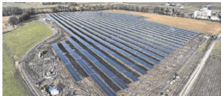
Inbetriebnahme der Agri-PV-Anlage in Herbstheim
