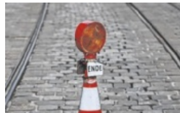
Gleisarbeiten führen zu Bim-Unterbrechungen. Foto: VOLKER WEIHBOLD
