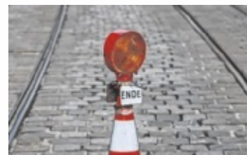
Gleisarbeiten führen zu Bim-Unterbrechungen. Foto: VOLKER WEIHBOLD
