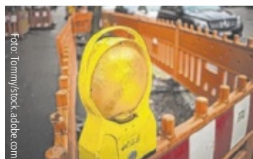
Die Weilhartstraße wird saniert.
