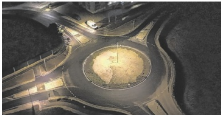
Bölick auf den neuen Kreisverkehr
