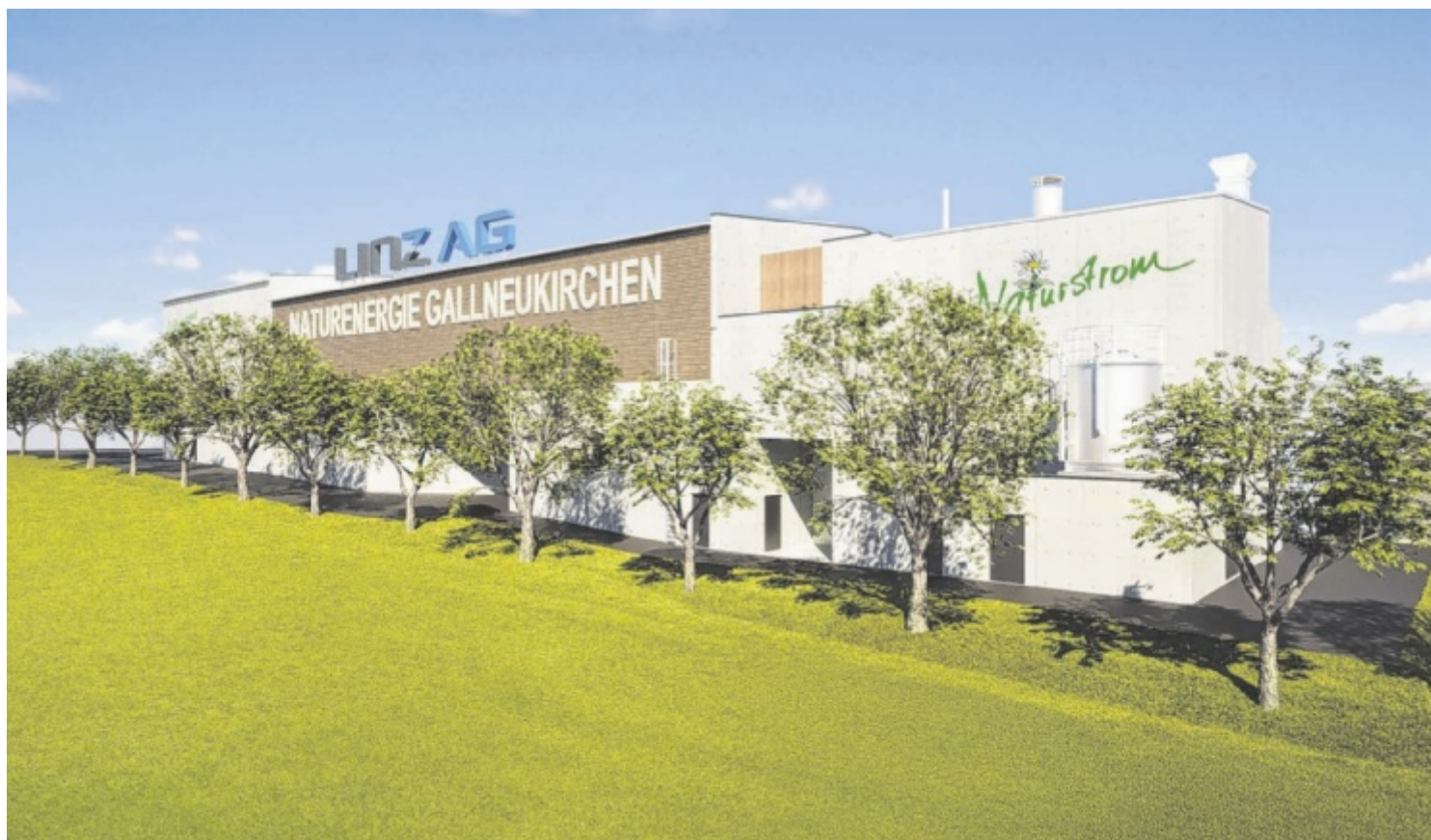
Ab Herbst 2026 sorgt das neue Biomasseheizkraftwerk in Gallneukirchen für nachhaltige Wärme und grünen Strom – direkt aus der Region.
