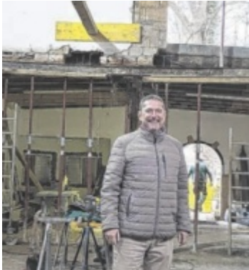
Stadtrat Christian Baumgarten auf der Baustelle. Foto: SPÖ
