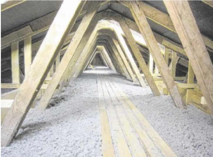
Bei ungenutzten Dachböden wird ein großflockiger Dämmstoff maschinell auf den nicht begangenen Flächen der obersten Geschossdecke verteilt. Foto: Climacell
