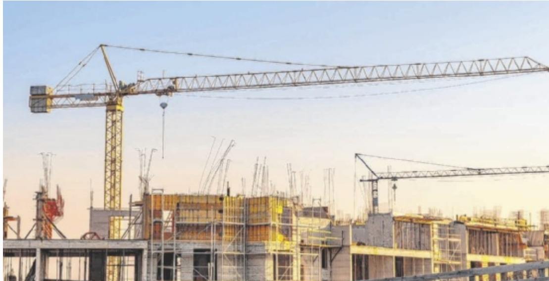
Trotz des Einbruchs im Vergleich zu den Rekordjahren hält sich der Wohnungsneubau in Oberösterreich entgegen den Bundestrends derzeit recht konstant. Foto: EdNurg/stock.adobe.com
