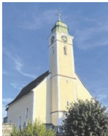
Die Kirchensanierung in Eitzing schreitet voran.
