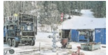
Geräte und Ausrüstung für die Testarbeiten sind bereits vor Ort. Foto: ADX Energy
