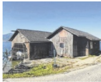
Die Bootshütten im Zentrum der Auseinandersetzung.
