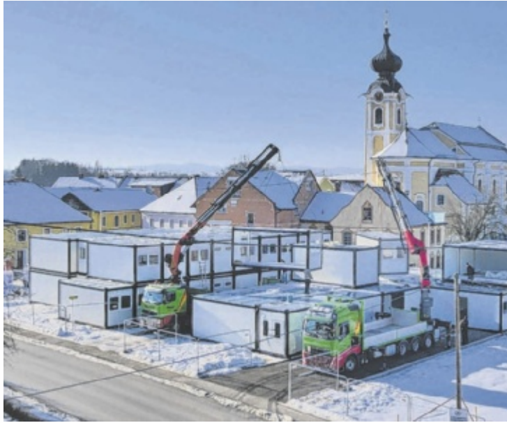
88 Container wurden in Hofkirchen aufgestellt, um für Krabbelstube, Kindergarten und Volksschule ein Übergangsquartier zu schaffen. Foto: Gerhard Schrödl
