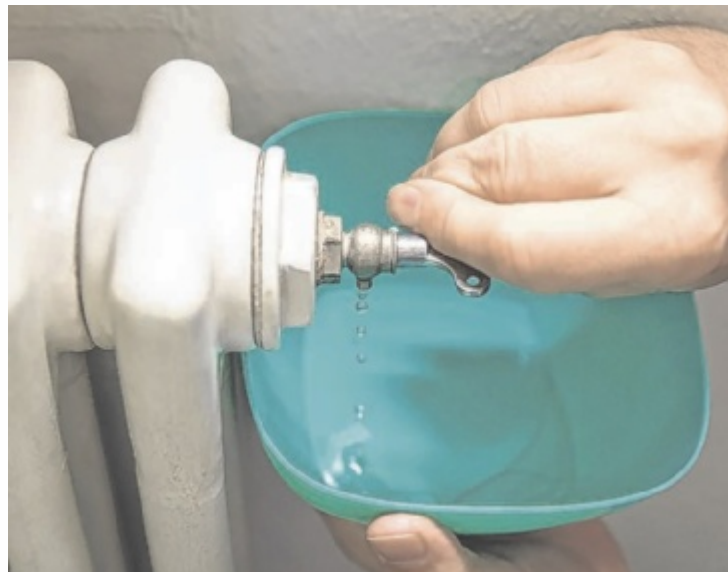
Wenn die Heizkörper nicht so warm werden, wie sie sollten, sollten sie vielleicht einfach nur entlüftet werden. Foto: Miriam Doerr & Martin Frommherz/stock.adobe.com
