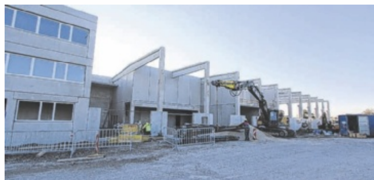
Die Halle 17 entsteht in Beton-Fertigteil-Bauweise.
