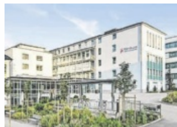
Der Klinikum-Standort in Grieskirchen
