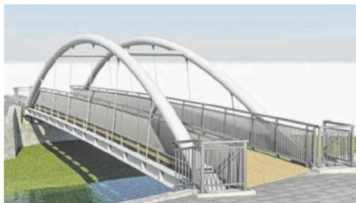
Die Fußgänger- und Radbrücke wird als Bogenbrücke gebaut.
