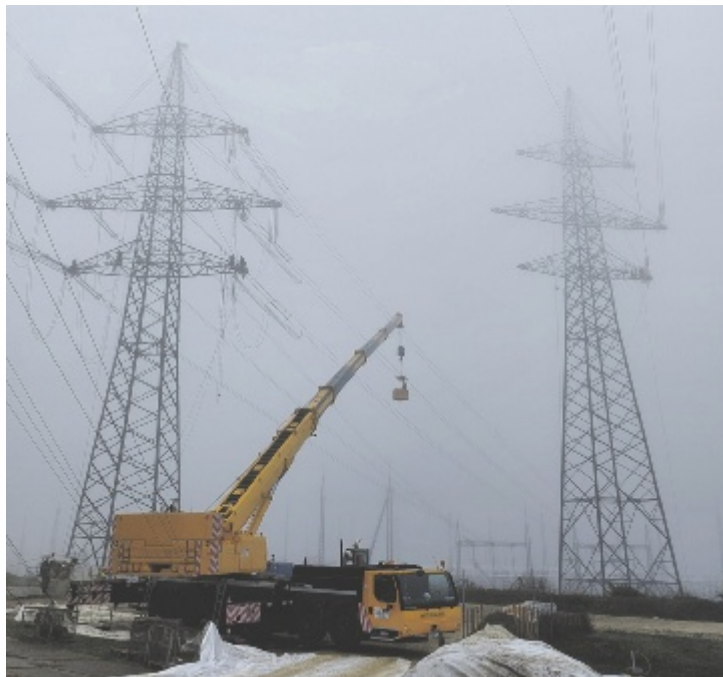
Dieser Tage werden die letzten Kabel vom rechten auf den linken neuen Mast umgeschwenkt. Der rechte Mast wird dann schrittweise abgebaut. Foto: Tips/Matschek
