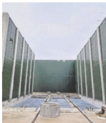
Entlang der Schienen werden die Trafos in die Boxen geschoben. Foto: Tips
