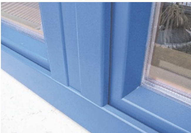
Saniertes Fenster mit Aluminiumverkleidung
