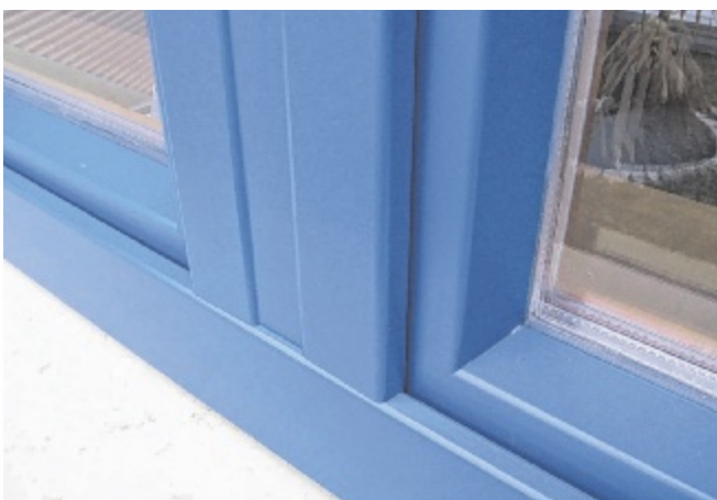
Saniertes Fenster mit Aluminiumverkleidung
