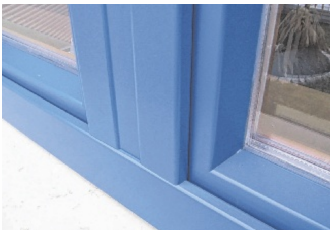
Saniertes Fenster mit Aluminiumverkleidung
