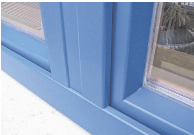
Saniertes Fenster mit Aluminiumverkleidung
