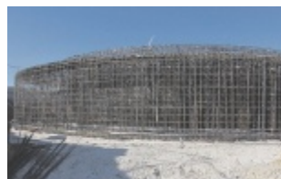
Stahlkorb für Windradfundament
