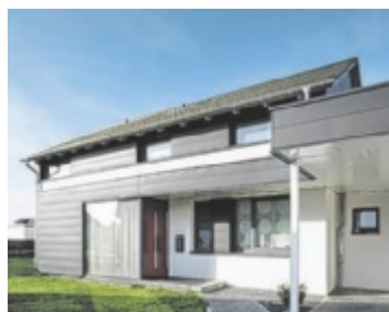
Ein Haus mit einer hinterlüfteten Aluminium-Fassade Foto: epr/Prefa/Croce&Wir
