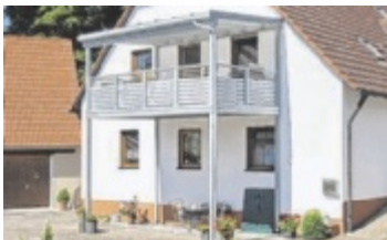
Vorstellbalkon mit Stützen Foto: Leeb
