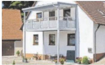
Vorstellbalkon mit Stützen
