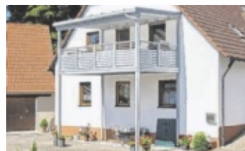
Vorstellbalkon mit Stützen
