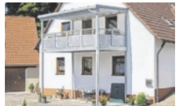
Vorstellbalkon mit Stützen
