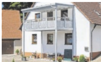
Vorstellbalkon mit Stützen
