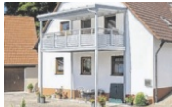
Vorstellbalkon mit Stützen
