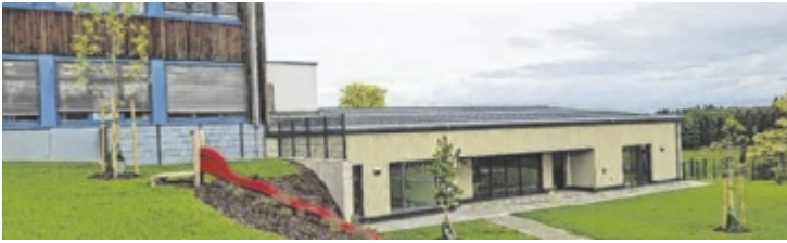
Der Anbau wurde in Holzmassivbauweise umgesetzt.
