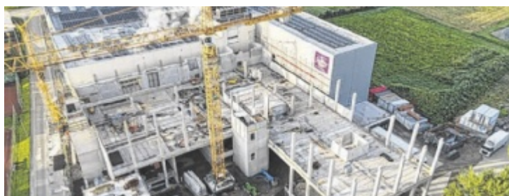
Aktueller Bauzwischenstand im August 2025
