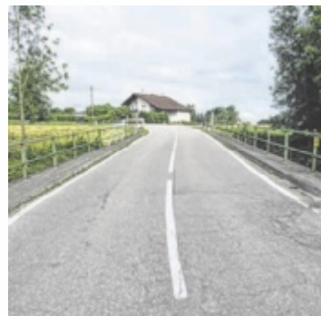
Die Mühlbachbrücke wird abgerissen und neu gebaut.
