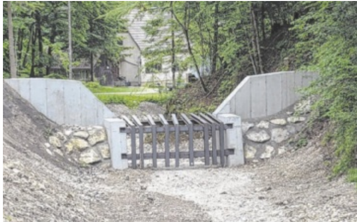
Diese Geschießerückhaltesperre am Aubodenbach in Hollenstein verhindert, dass große Mengen an Steinen, Geröll und Schlamm zum Grundstück gelangen. Foto: WLW
