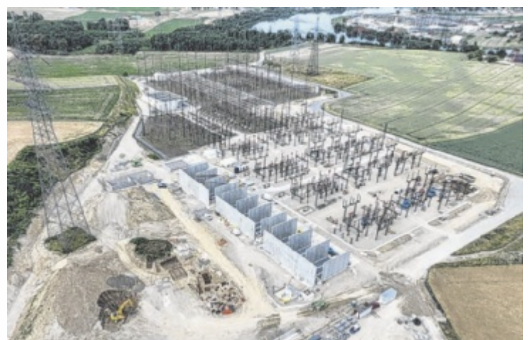
Das Schaltwerk wird zum Umspannwerk umgebaut.
