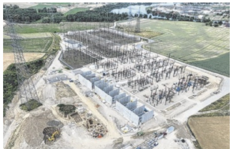
Das Schaltwerk wird zum Umspannwerk umgebaut.
