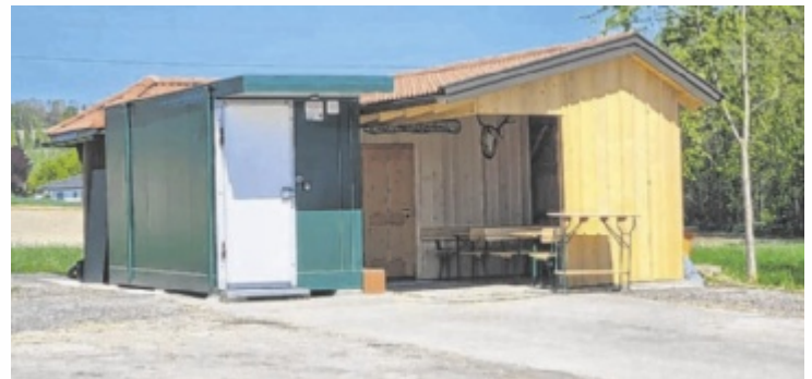
Die neue Jagdhütte befindet sich direkt im Ortszentrum. Foto: Jägerschaft Bezirk Schärding
