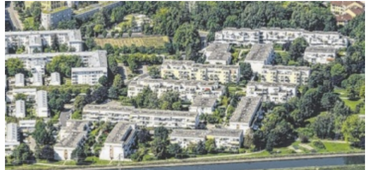
Die GWG saniert die Wohnanlage in der Hallestraße. Foto: H. Pertlwieser / PTU
