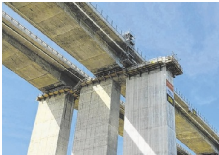
Querverschub des Fahrstreifens Richtung Wien neben die andere Fahrbahn.
