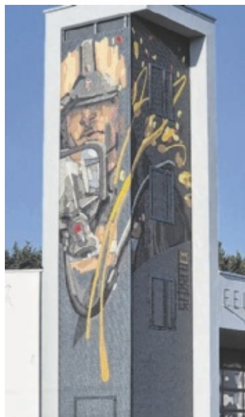
Den Schlauchturm zielt ein Feuerwehrmann im Graffitistil. Foto: Gemeinde St. Roman
